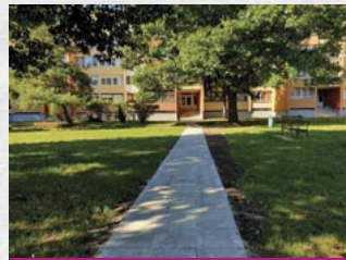
Járdafelújítás a Pázmányon
